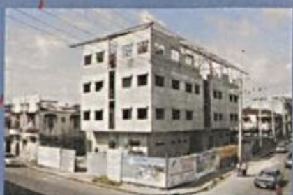
Construcción del Policentro de Salud de Colón
